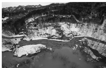
図-2 国道239号霧立峠近くで発生した地すべり 2012年4月26日 北海道開発局提供
