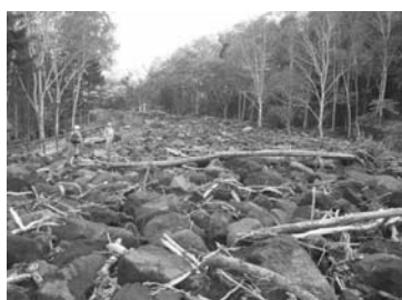
図-5 国道 453 号を埋めた土石流 北海道開発局提供
