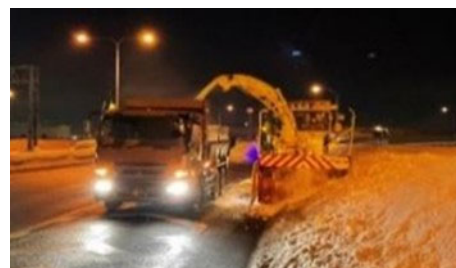
図13 夜間通行止め時の排雪作業
