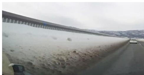
図12 除雪より路肩が飽和した状況
